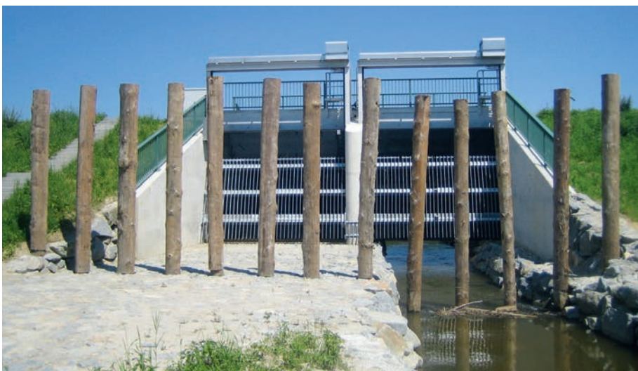
Hochwasserrückhaltebecken Langenneufnach – Baumstämme schützen das Bauwerk bei Hochwasser vor mitgeschwemmtem Holz.
