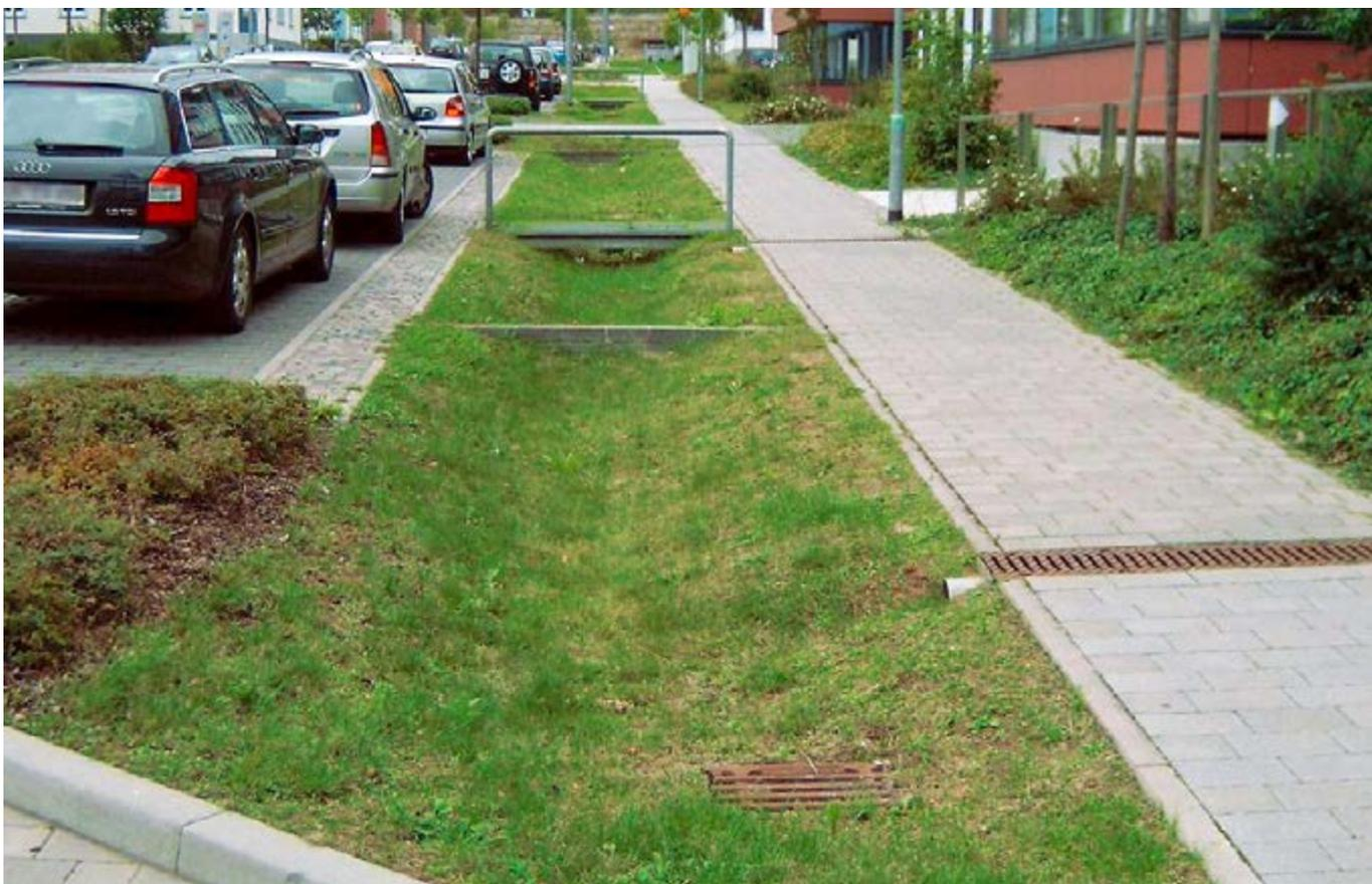
Abb. 1: Funktional – herkömmliche Versickerungsmulde mit Rasenbegrünung.
