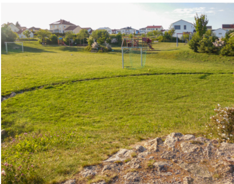
Abb 3: Multifunktionale Rückhaltefläche in einer Siedlung
